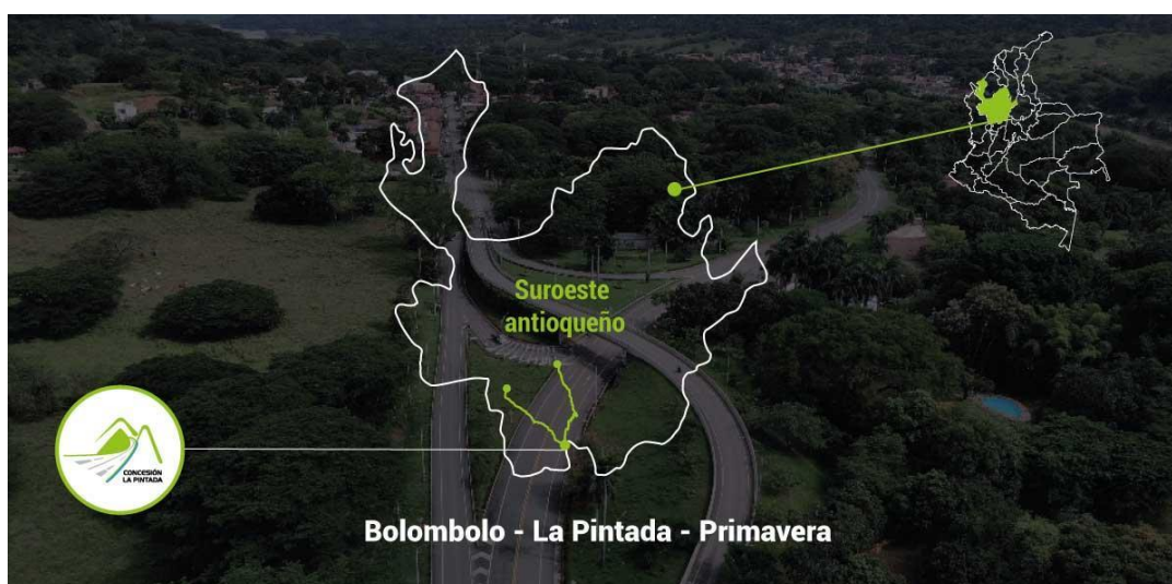
Ilustración 132. Localización obras Pacifico 2.
