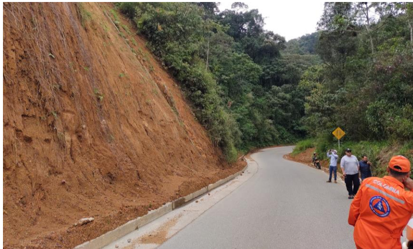
Figura 35. Perfil de meteorización del Miembro Volcánico, vía a Angelópolis. Fuente: Estudio básico de amenazas Caldas (2021)
