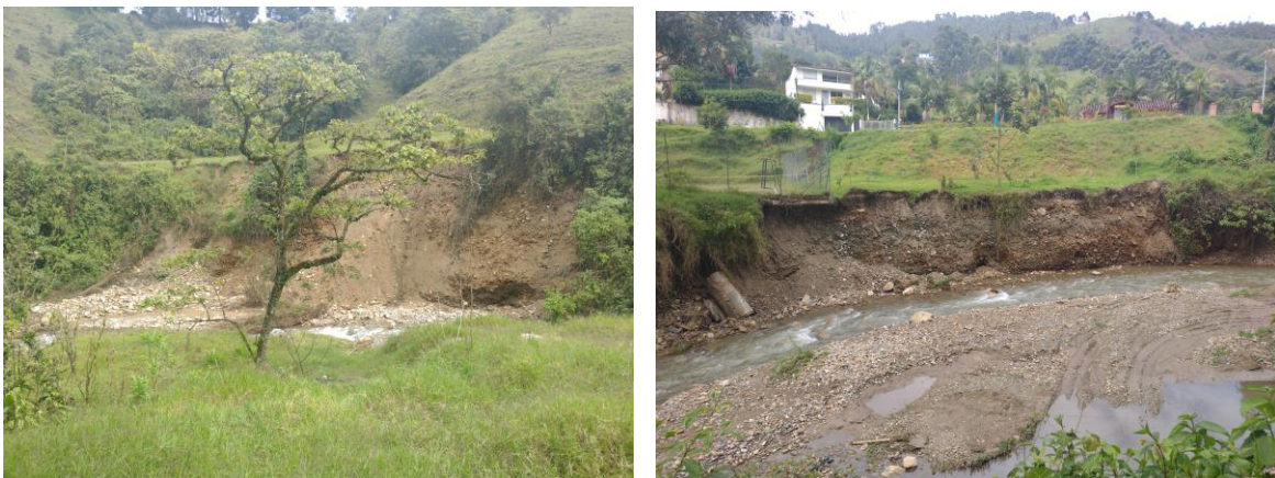
Figura 60. Socavación Lateral quebrada La Miel. Fuente: Estudio básico de amenazas Caldas (2021)
