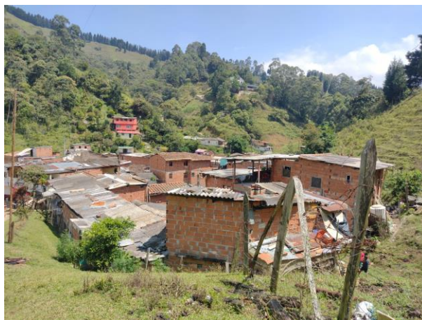
Figura 169. Viviendas del centro poblado La Valeria ubicadas sobre depósitos de deslizamiento.
