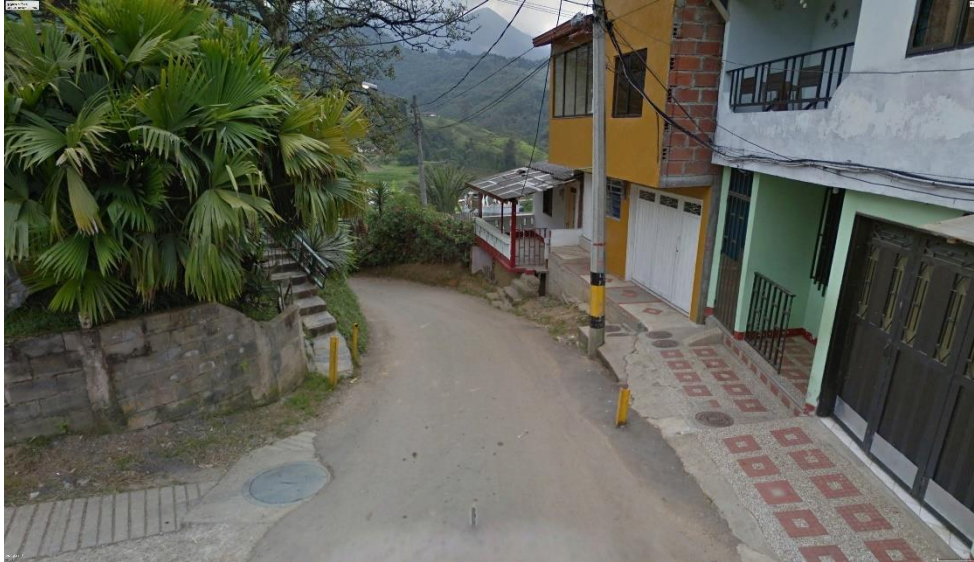
Figura 7-21. Redes de alcantarillado barrio Primavera. Fuente: Google Earth-2023.
