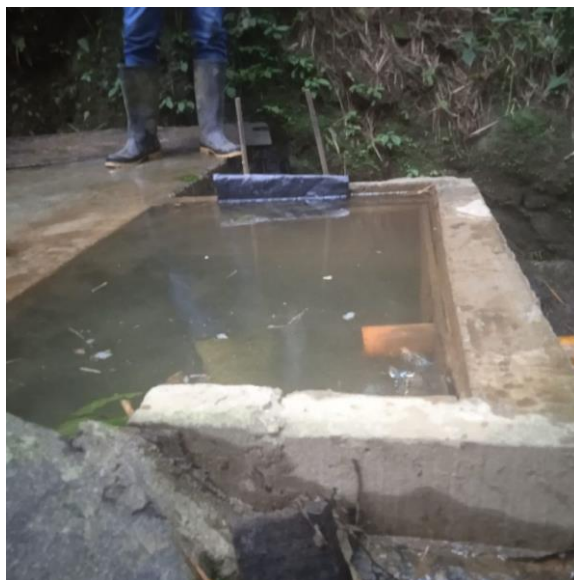
Figura 7-13. Captación del acueducto veredal La Corrala parte alta. Fuente: Proyecto 8 AMVA 2021
