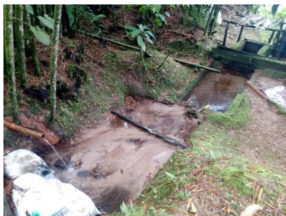
Figura 7-19. Captación del acueducto JAC vereda La Miel. Fuente: Proyecto 8 AMVA- 2021.
