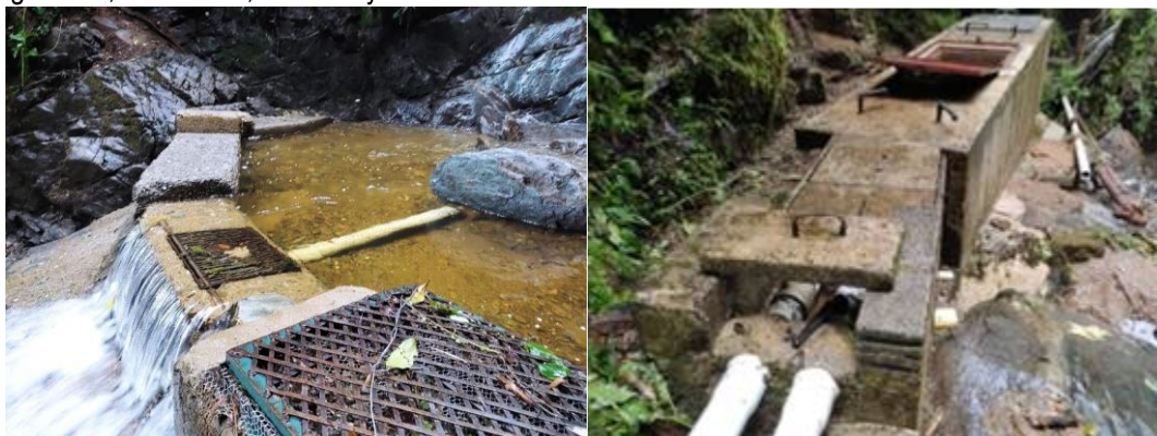
Figura 7-16. Captación y desarenador del acueducto Multiveredal. Fuente: Informe Técnico 160AS-IT2111-13363 del 22 de noviembre de 2021.
