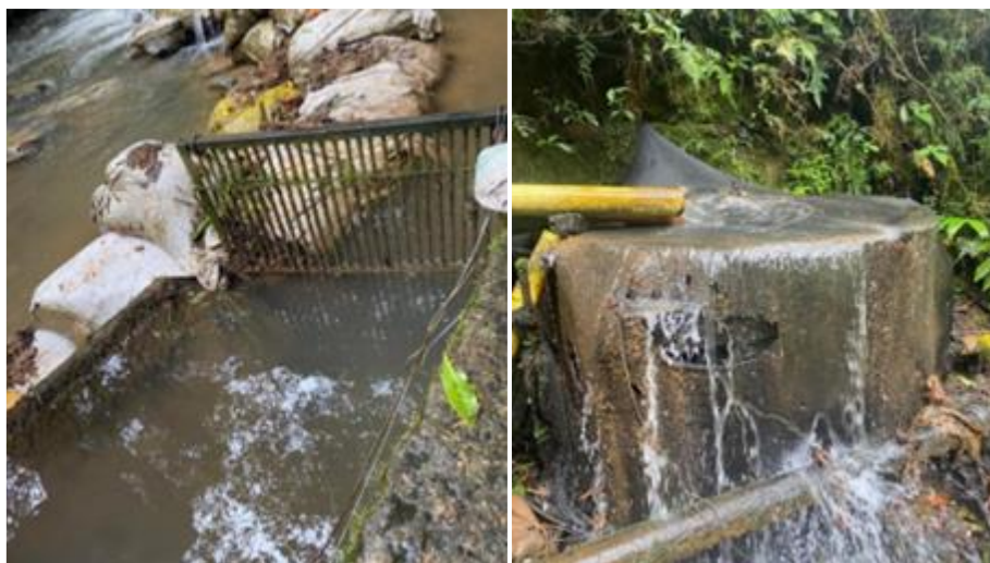
Figura 7-17. Componentes del acueducto La Salada parte baja. Fuente: informe técnico 160AS-IT2305-5450.
