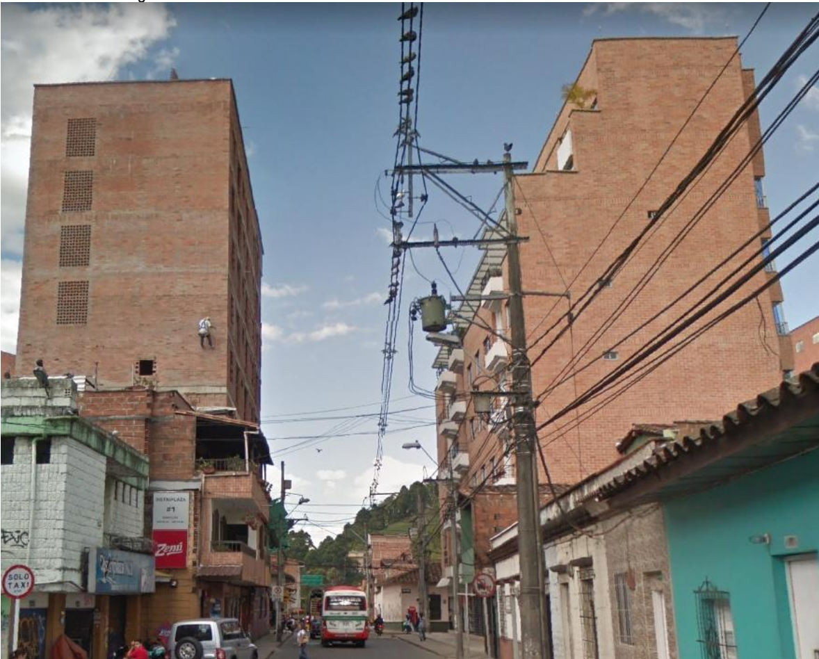
Fotografía 33: Nuevos desarrollos de vivienda en altura sobre el corredor de la carrera 48.
