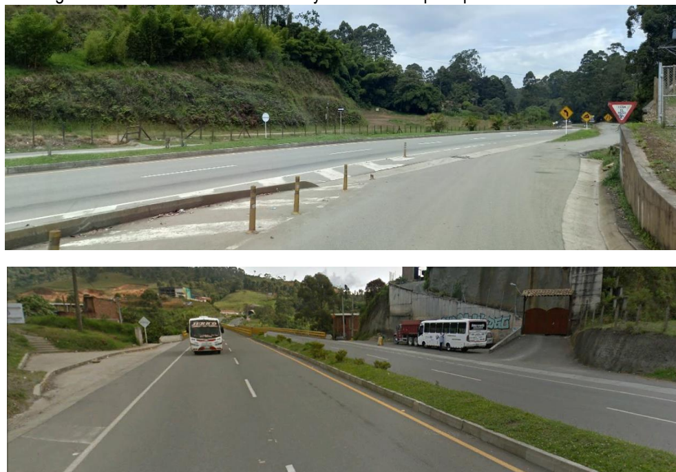
Figura 24. Conexión vereda la Tolva y conexión vía principal concesión Pacifico 1.
