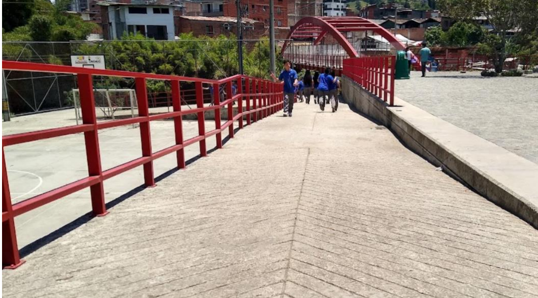
Figura 9 Acceso Parque Tres Aguas desde la Plazoleta Fuente: Google Maps
